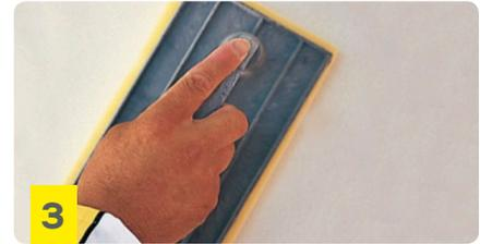
Frotar en forma circular cada una de las aplicaciones comenzado el proceso de endurecimiento, pasar una flota para dar acabado deseado.
