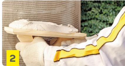
Extender de modo uniforme el producto con una llana plana metálica en dos manos hasta obtener un espesor de aproximadamente 3 mm.
