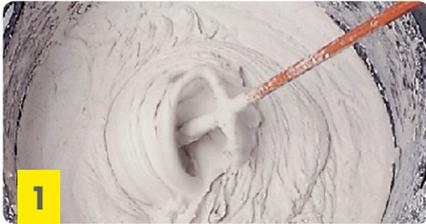
Amasar con aproximadamente 6/7 litros de agua limpia por bolsa de 40kg, manual o mecánicamente, hasta lograr una pasta homogénea. Dejar reposar aproximadamente 10 min.
